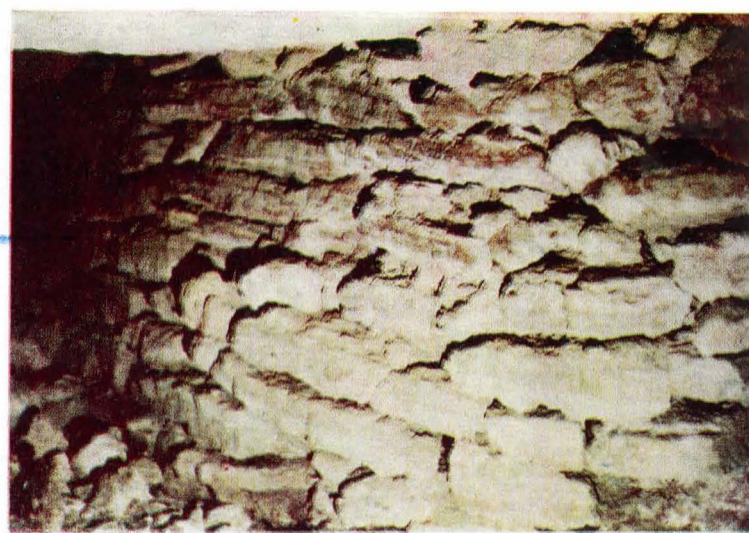
Fig. 24 — Zidul din galeria 48 a sectorul III
